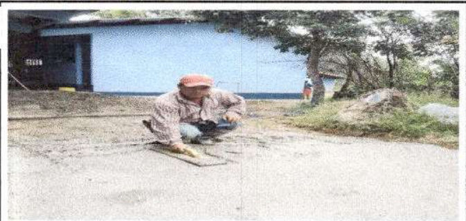
Foto 5: Reparacion de planchas de concreto de patio
