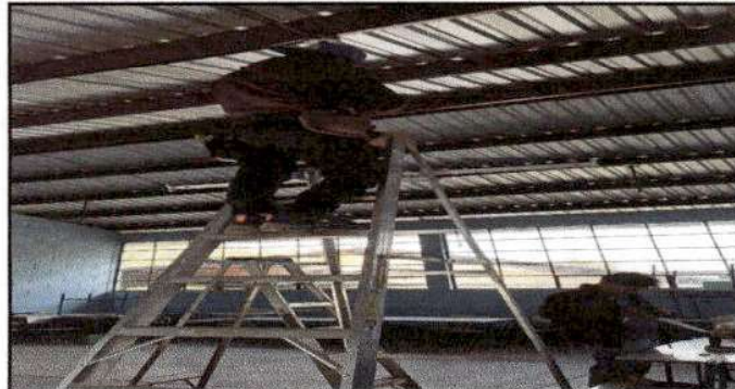
Foto 8 : Colocando Lamparas de 2 x 40 marca led.
